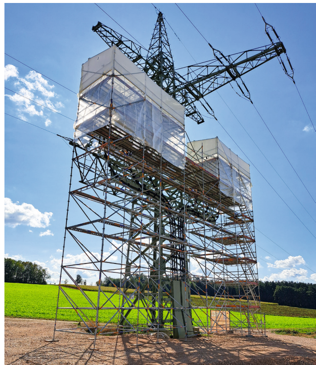
Abbildung 4: Am eingehaustem Mast wird das Kabel an die Freileitung Sittling-Regensburg angeschlossen.
