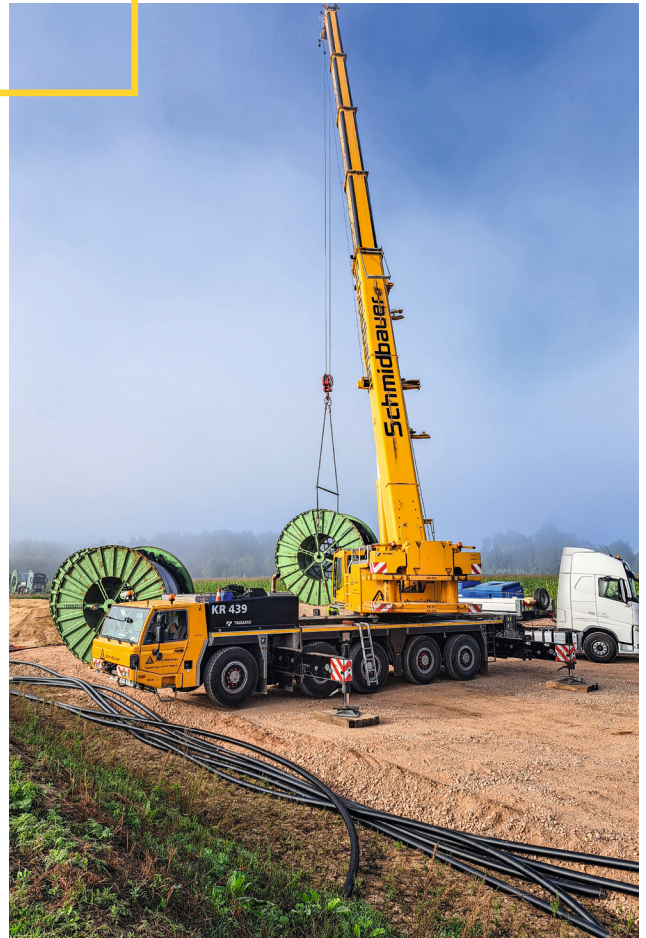
Abbildung 1: Ein Kran lädt die Kabeltrommeln vom Anlieferungsfahrzeug ab. ©Foto: Bayernwerk/Bernd Igelbüscher
