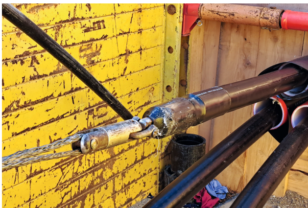
Abbildung 2: Der Kabeleinzug in der Nahaufnahme. ©Foto: Bayernwerk/Bernd Igelbüscher
